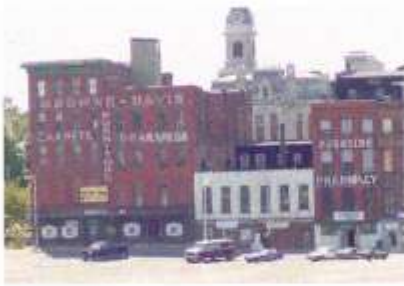
Osweg Left Side
